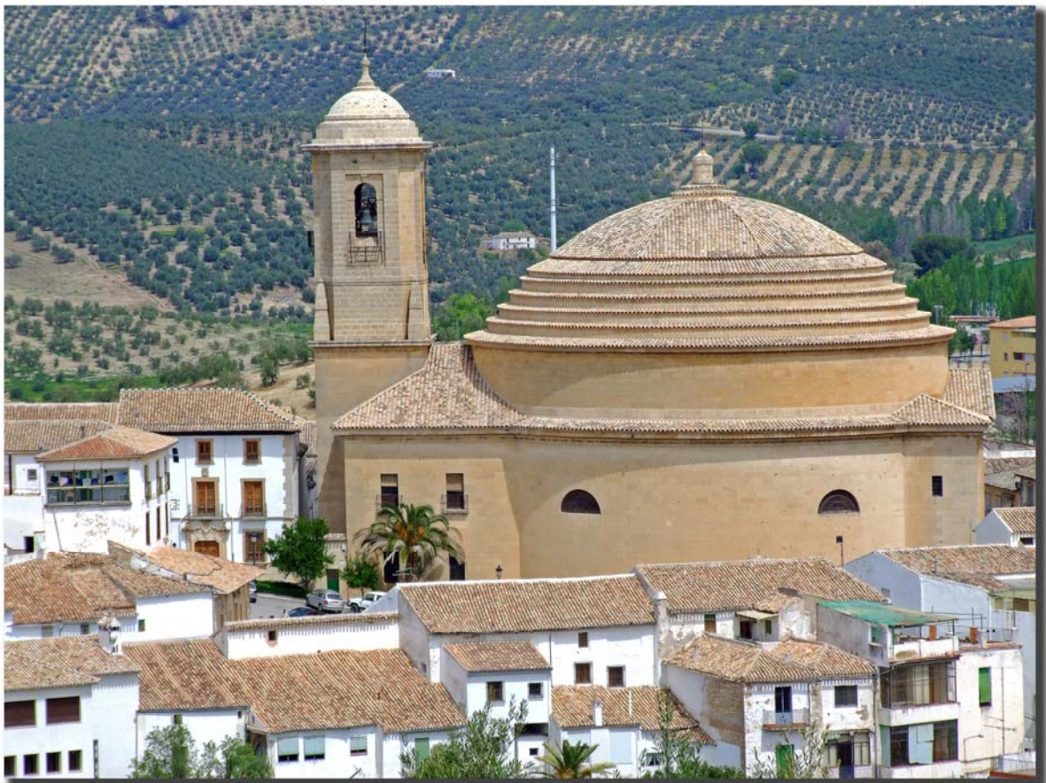
Img. 11: Vista lateral al S-O.
